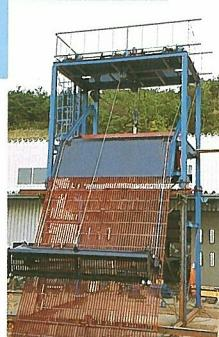
3本のワイヤーに懸架されたレーキによって、水路内の夾雑物を自動的に掻き揚げる大型の流水除塵機です。
