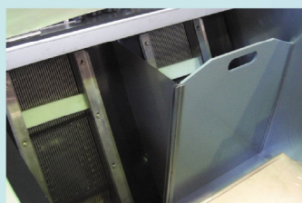
流路切替用角落し
