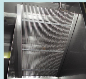
バイパス用固定スクリーン (S: 5mm)
